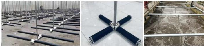
可提升曝气装置，使用寿命长，便于维护。
