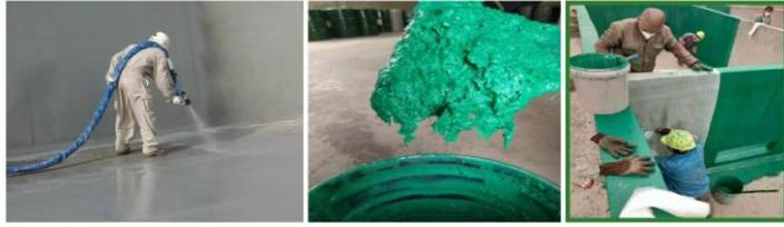
聚脲防腐      玻璃鳞片防腐      三布五油防腐
